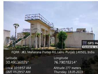
Lalru STP-1.5 MLD
